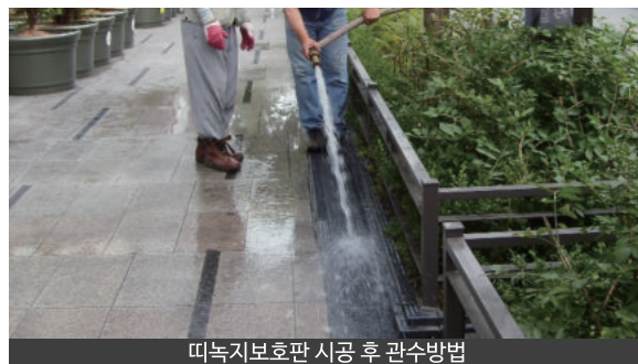
띠녹지보호판 시공 후 관수방법
