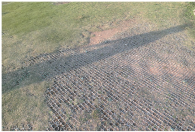
기타 잔디보호매트 시공 사례
