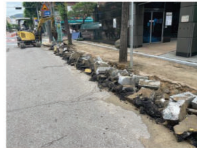
기존 경계석 철거 및 폐기
