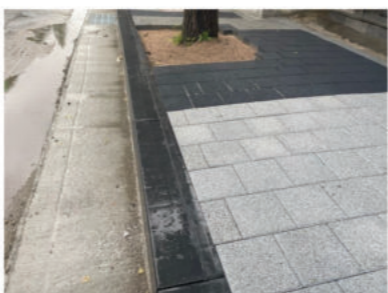
주변정리 후 시공 마무리
