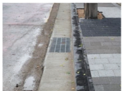
거푸집 해체, 측구(빗물받이) 설치
