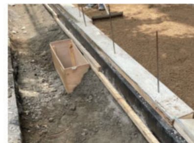
2차 Conic타설, 측구 거푸집 설치
