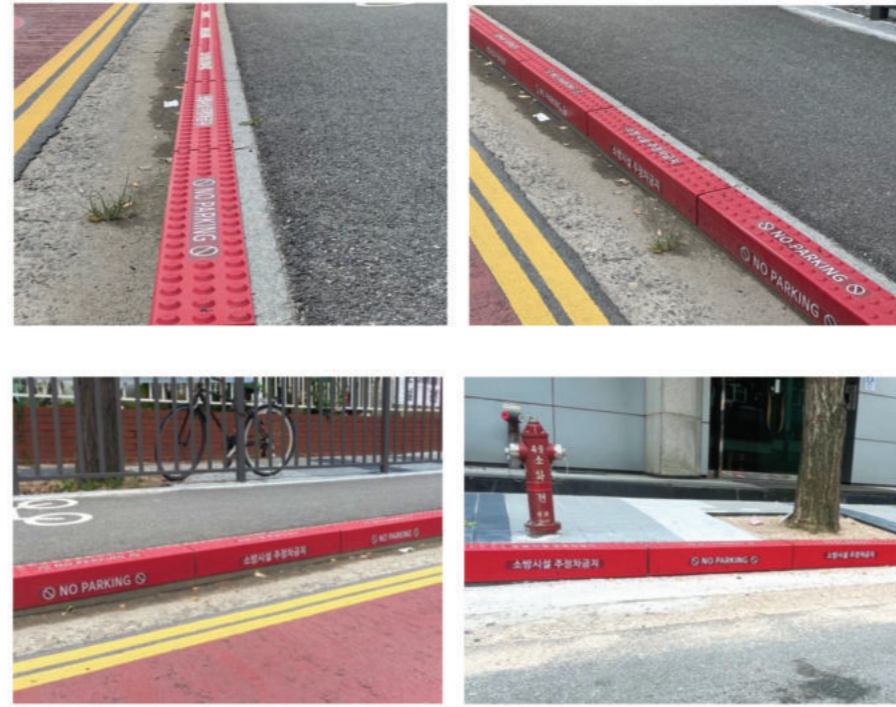
〈당사〉 시그널 특화 안내 커버 “소화존” 시공
