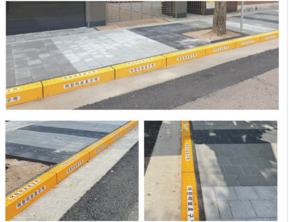
〈당사〉 시그널 특화 안내 커버 “스쿨존” 시공
