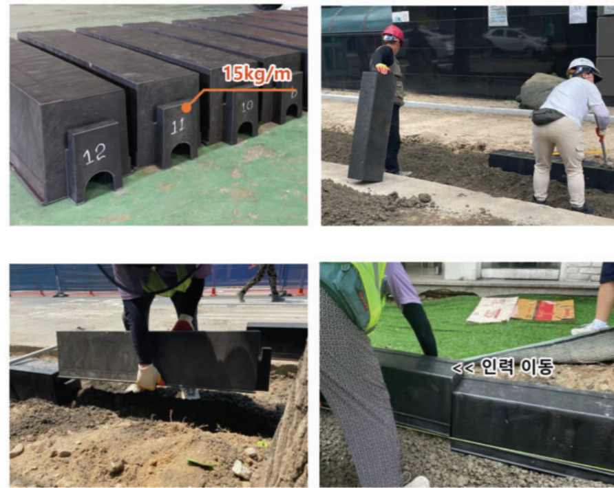
<당사> 폐비닐재활용 특수블록 시공
