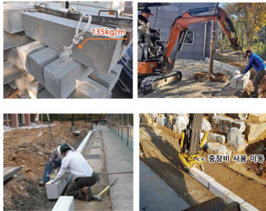
<기존> 자연·인조(콘크리트)경계석 시공
