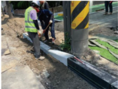
낮춤석, 내림석 설치
