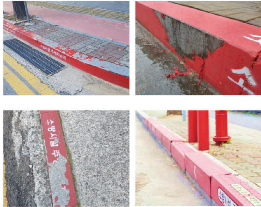
〈타업체〉 시트 부착·페인트 등 “소화존” 시공
