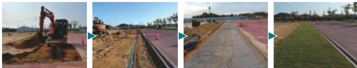
① 지반평탄화 및 터파기 포크 작업 ② 빗물저금통과 물공급 호스 설치 ③ 수분유지 보온덮개 설치 ④ 토사 포설 후 보호매트와 잔디 압착
